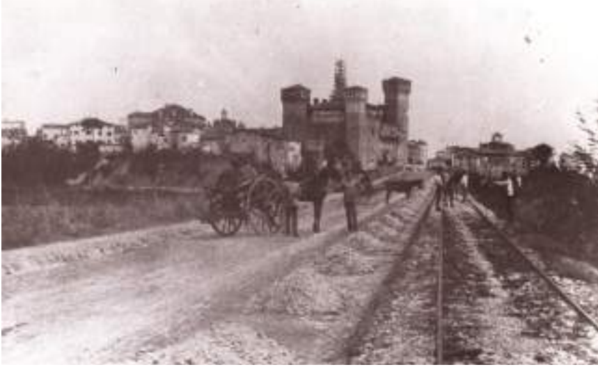
Vista storica sul ponte Muratori verso la Rocca
