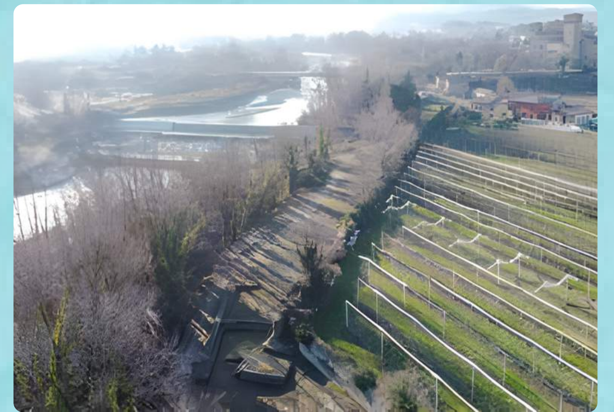
Un tratto del Percorso Natura a nord del centro di Vignola, in direzione Spilamberto: un itinerario ciclopedonale di quasi 34 km che costeggia il fiume Panaro da Modena Est (ponte di Sant' Ambrogio) fino a Casona di Marano, passando per San Donnino, Spilamberto e Vignola. Immerso nel verde, offre un paesaggio fluviale facile da percorrere, spesso chiamato "Percorso Sole" nel tratto vignolese
