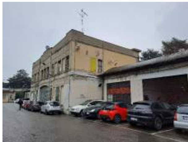
Edificio dell'Ex Mercato Ortofrutticolo
