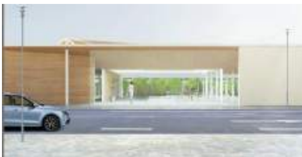
Ingresso via Plessi
