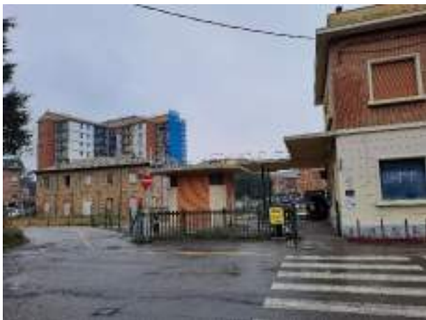
Fabbricato Viaggiatori e pertinenze – lato est
