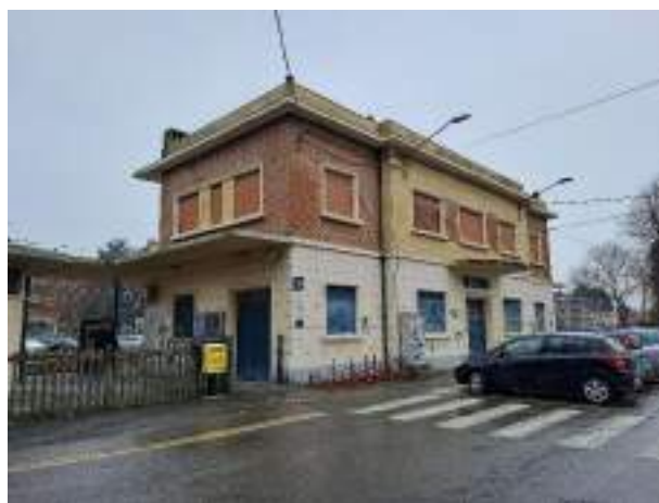
Fabbricato Viaggiatori e pertinenze – lato sud-est
