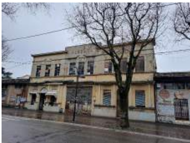
Edificio dell'Ex Mercato Ortofrutticolo
