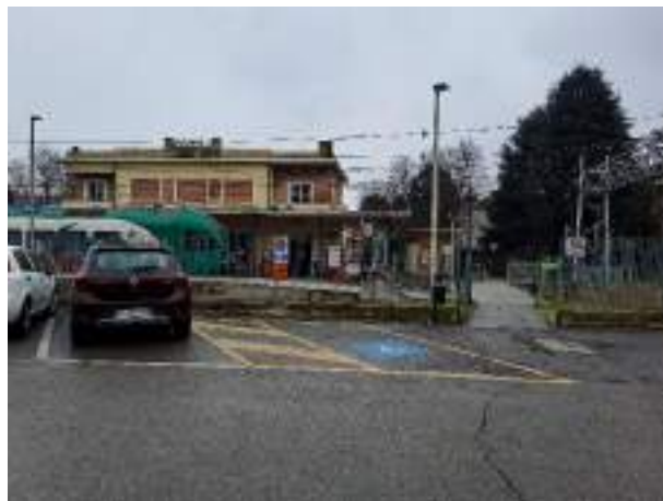
Fabbricato Viaggiatori e pertinenze – lato ovest
