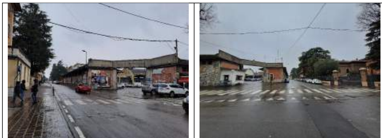
Accesso all'Ex Mercato da via MAZZINI
