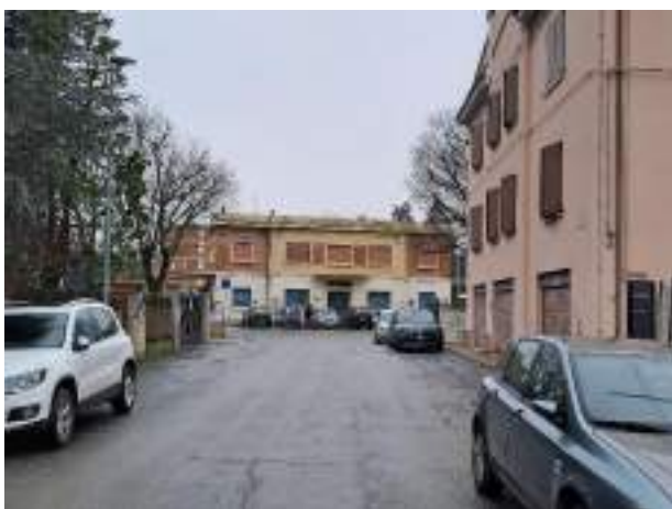
Fabbricato Viaggiatori e pertinenze – lato est
