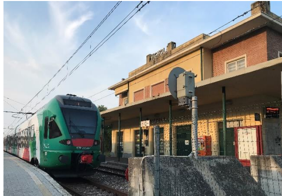
Immagine 3.2.10: la stazione oggi
