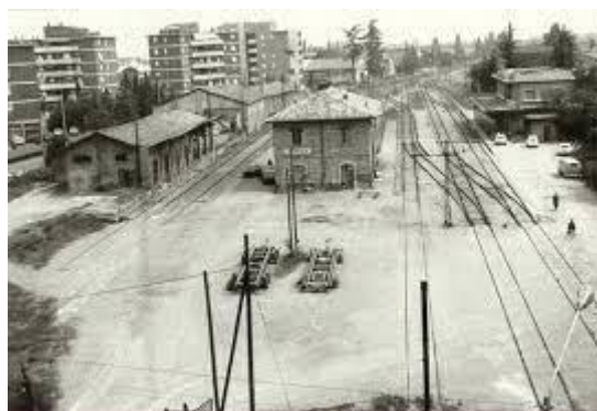
Immagine 3.2.9: la stazione con i vecchi edifici
