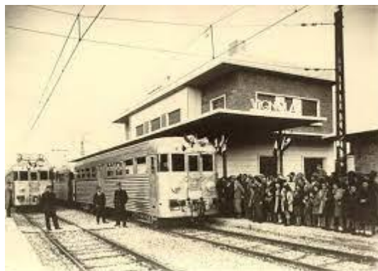
Immagine 3.2.8: la stazione ed i primi due treni della nuova linea elettrica 1938
