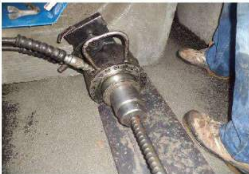
Predisposizione sistemi di post-tensionamento
