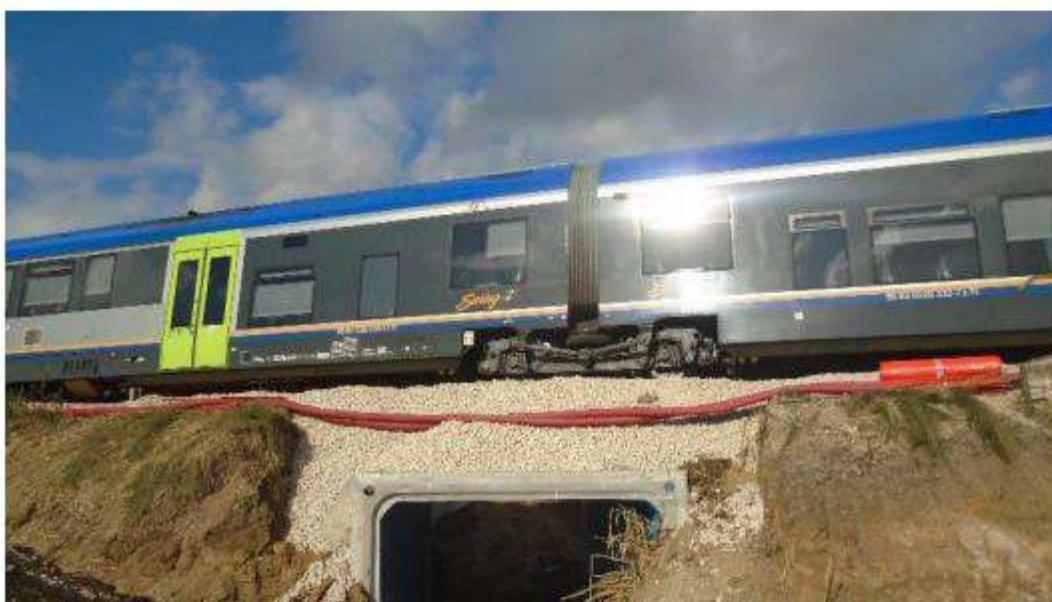
Posizionamento dei prefabbricati nello scavo a cielo aperto
